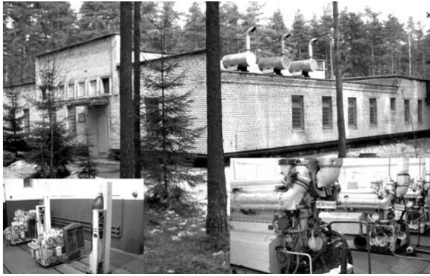
Учебно-резервная и научно-исследовательская дизельная электростанция (УР ДЭС) общей мощностью 1630 кВт
