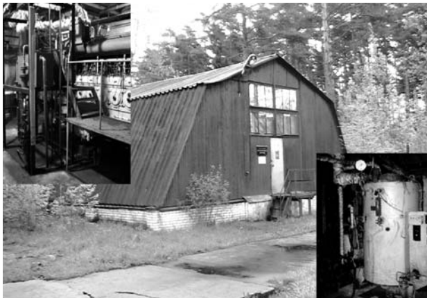
Экспериментальный «Энергоблок» для электро-тепло-снабжения войск, оборудованный дизель-генераторами ДГА-315 и котлоагрегатами МЗК-7АЖ
