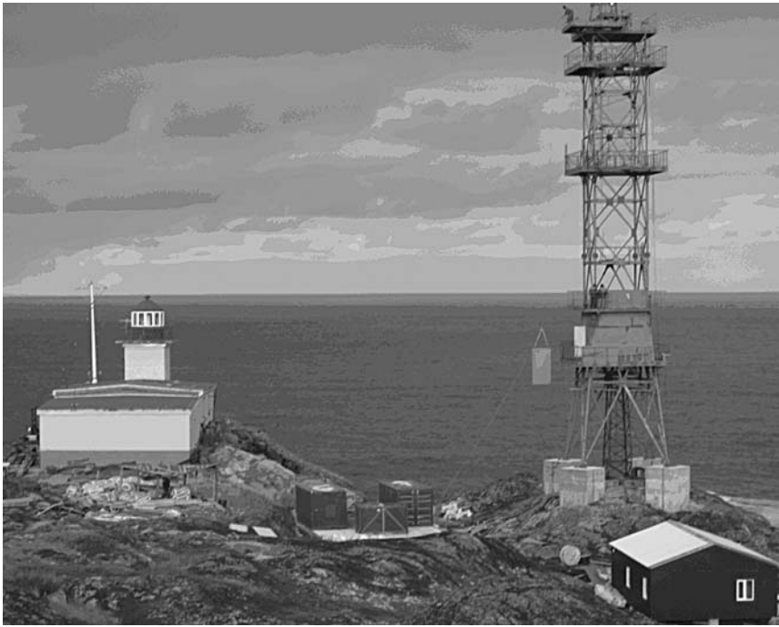
Рис. 2. Размещение оборудования ветродизельного энергокомплекса на объекте (мыс Сеть-Наволоок)
