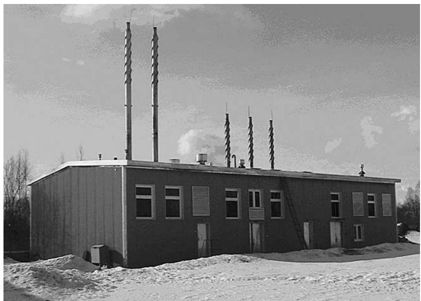
Рис. 3. Блочно-модульный энергетический комплекс
