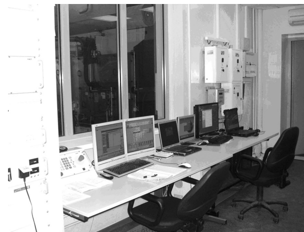
Рис. 2. Вид пультового помещения испытательного стенда
