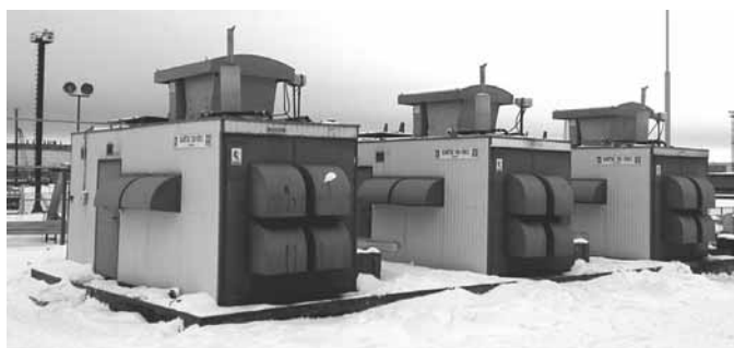
Рис. 6. Теплоэлектростанция на базе трех модулей КамТЭС 100-1К
