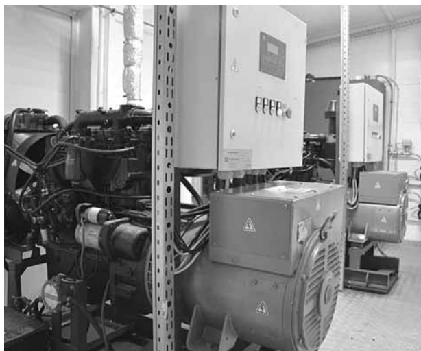
ДЭУ типа АД мощностью 30 кВт со шкафом управления на базе контроллера типа ПН
