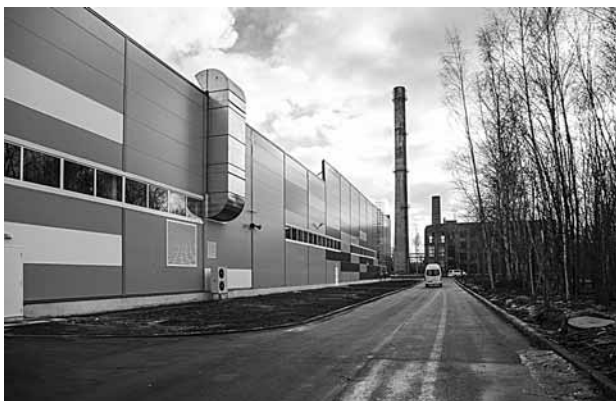
Рис. 1. Корпус участка редукторного производства ПАО «Звезда»
