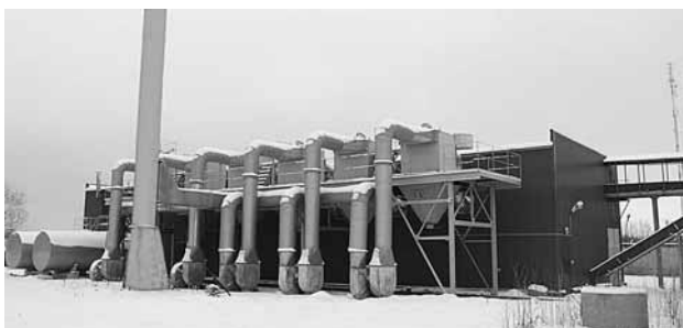
Рис. 3. Общий вид экспериментальной механизированной угольной котельной с котлами КВП-1.74-ВТКС (п. Горская, Ленинградской обл.)
