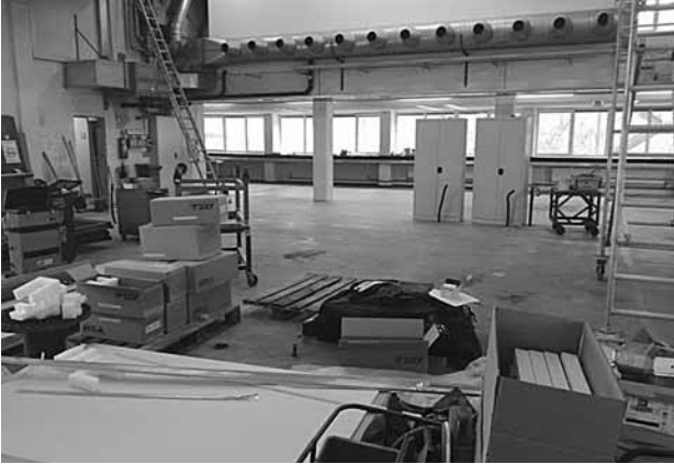
Рис. 2. Переоборудование существующего цеха
