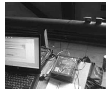
Рис. 7. Измерительный комплекс расхода сетевой и котловой воды
