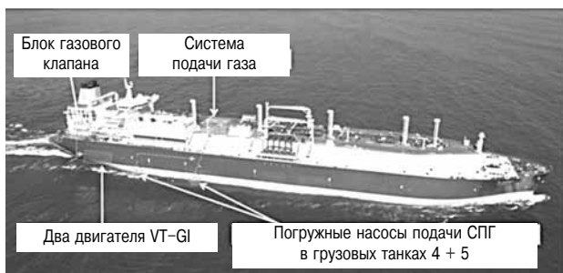
Рис. 2. Судно Rasheeda, на котором установлены два первых в мире двигателя 7S70ME-C7.1, переоборудованные в 7S70ME-C.7-GI
