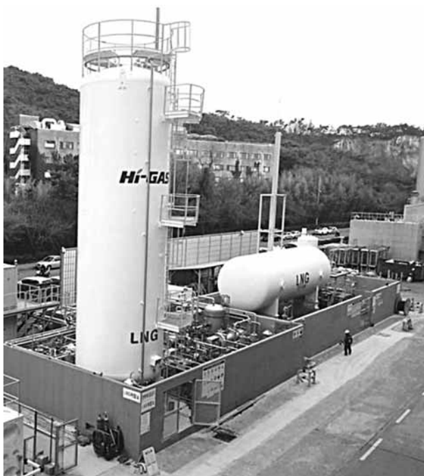
Рис. 8. Система подачи LNG на двигателях HHI-EMD
